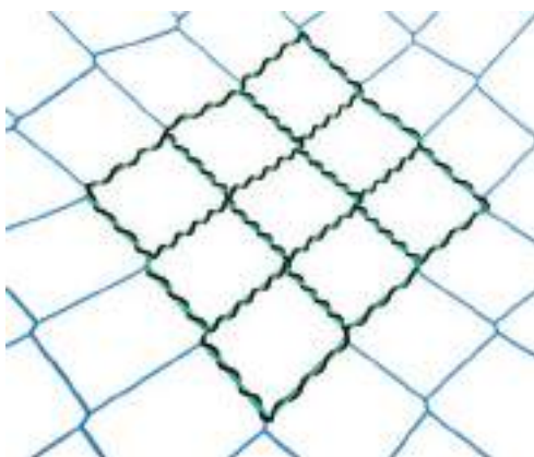
Figura 9.3.6-1 Riparazione di una rete di sicurezza
